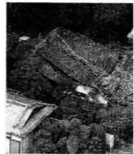
地震で倒壊した民家。16日午後、玉川加納市で、本社へリポート
