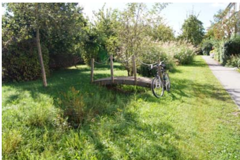
パブリックスペースにある雨水浸透設備(トレンチ)
