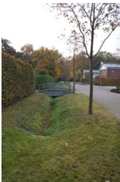
上手くデザインされた雨水排出システム(地区詳細計画では溝と指定されている場所)
