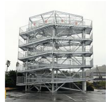
公民館の敷地内に完成した避難タワー（5日、静岡県御前崎市で）
