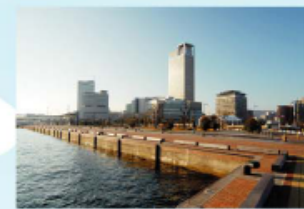
海水温差エネルギーによる地熱利用 サンポート浜川地区(豊川市浜川町)
