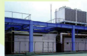
大規模ショッピングセンターに設置された天然ガスコージェネレーションシステム
