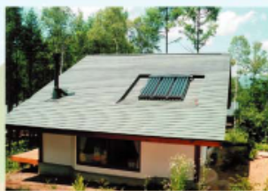
真田町南太陽熱温水器
